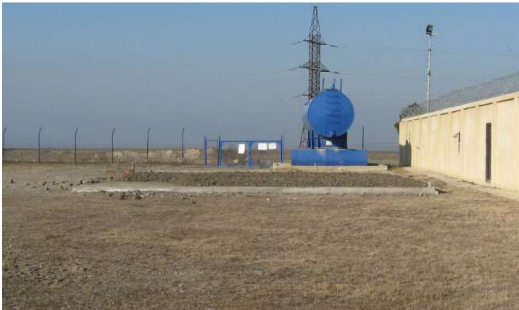
Рисунок д.11.5. Місце для рекультивациі забрудненого нафтопродуктами ґрунту
