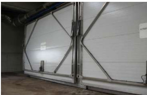
Зовнішній вигляд компостувальних тунелів
